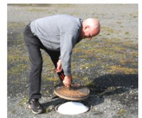
4. Das Isolierkissen einlegen, bevor der Deckel geschlossen wird.
