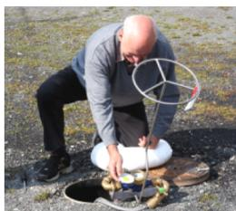
2. Durch die flexiblen Schläuche kann die Zähleranlage neben der Schachtoffnung abgelegt und abgelesen oder der Zähler ausgewechselt werden.
